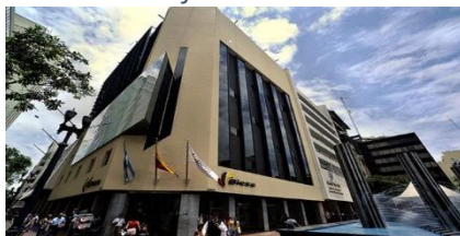
Ilustración 4 Edificio Ex Banco del Azuay
