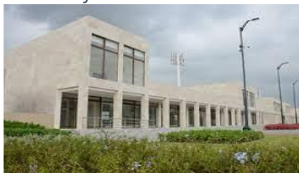
Ilustración 1 Edificio Administrativo en Samanes
