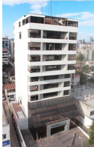
Ilustración 24 Edificio Cabrera Chávez
