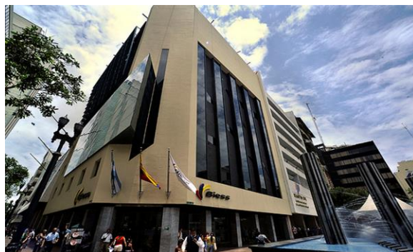
Ilustración 20 Edificio Ex Banco del Azuay
