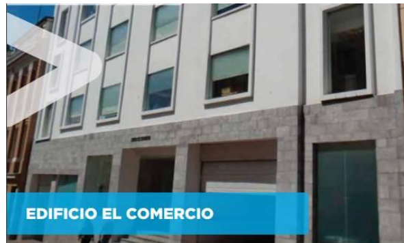
Ilustración 12 Edificio El Comercio
