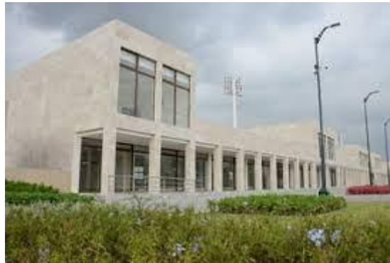
Ilustración 23 Edificio Administrativo en Samanes
